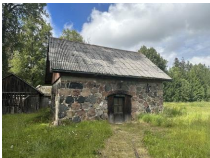
Katlu mājas fasāde
